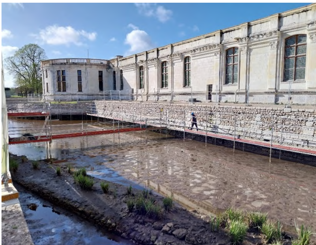
Figure 10 : Vestige d'un ouvrage maçonné visible lors de la vidange de la douve orientale (source : Chatillon Architectes)
